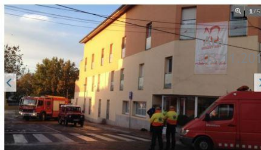
La residència afectada /SANTI IGLESÍAS
